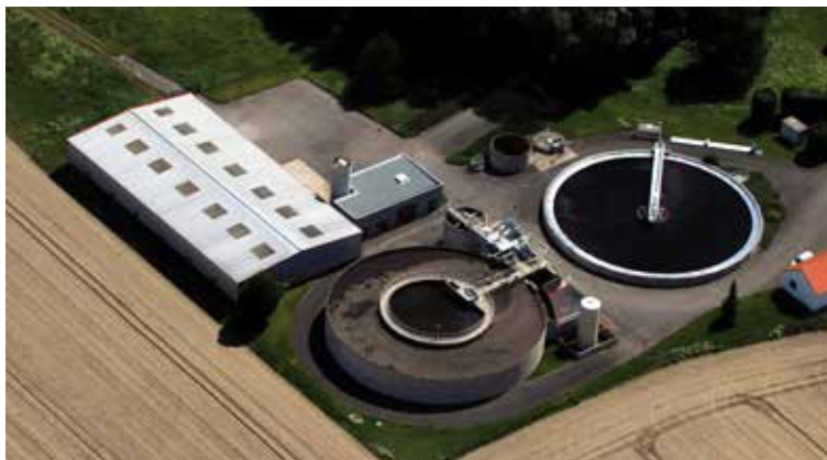
Ouvrage phare du système d'assainissement, la station d'épuration de Seltz a été mise à niveau en 2018 dans une optique d'économie d'énergie et d'amélioration des performances de traitement pour un montant de travaux de 1M€
